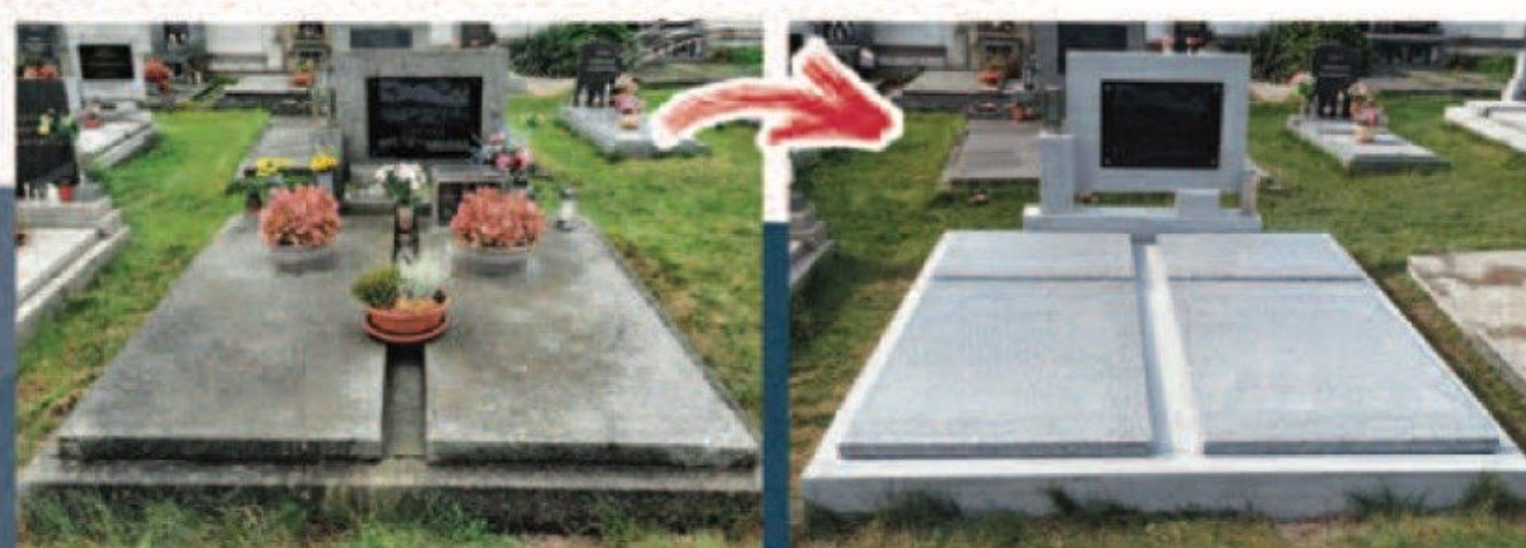
Ukázka realizace: broušení teracových rámců a výměna desek za žulové.
